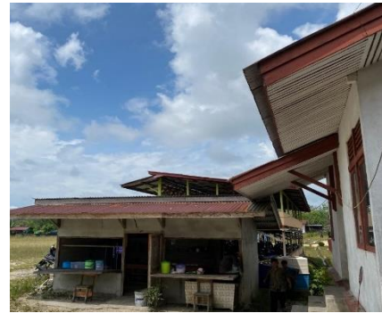
Kantin & Perpustakaan SD Negeri 10 Nanga Temenang
