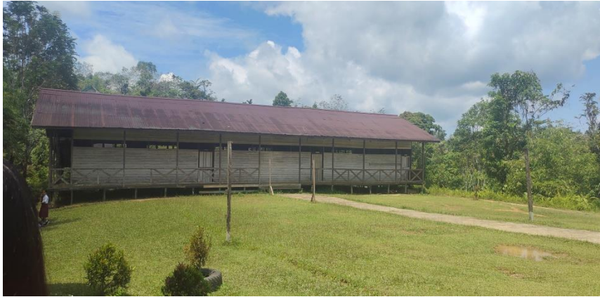
Bangunan gedung lama SD Negeri Tumbang Karuei
