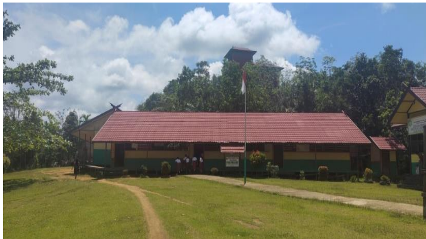
Bangunan gedung baru SD Negeri Tumbang Karuei
