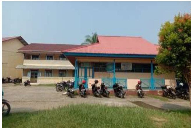
Gedung LAB SMK Nusantara Indah Sintang
