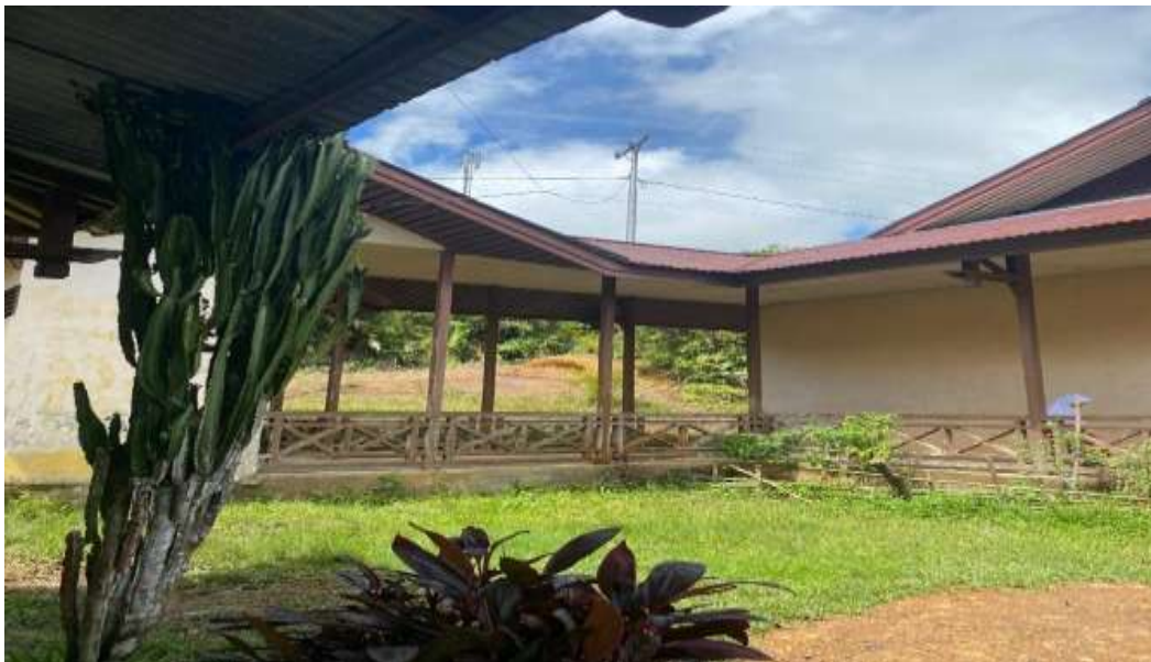
Gedung utama dan bangunan sebagai sarana belajar mengajar
